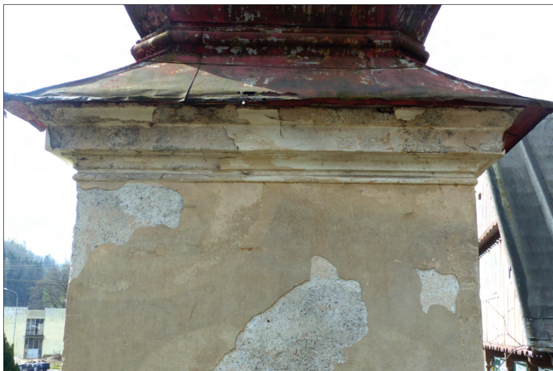
Obr. 8: Horní část severní stěny kaple s římsou a destrukcemi ve svrchních omítkových vrstvách
