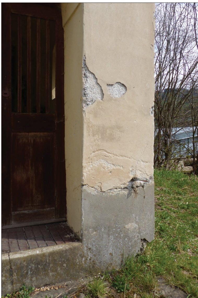
Obr. 31: Defekt nad hranou cementového soklu
