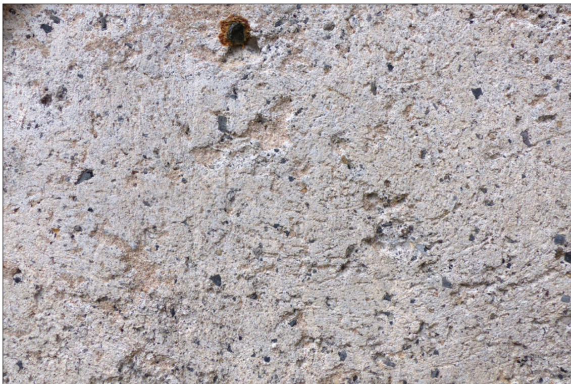
Obr. 21: Detail povrchu původní omítky, viditelně utaženého dřevem, bez stop dalších povrchových úprav
