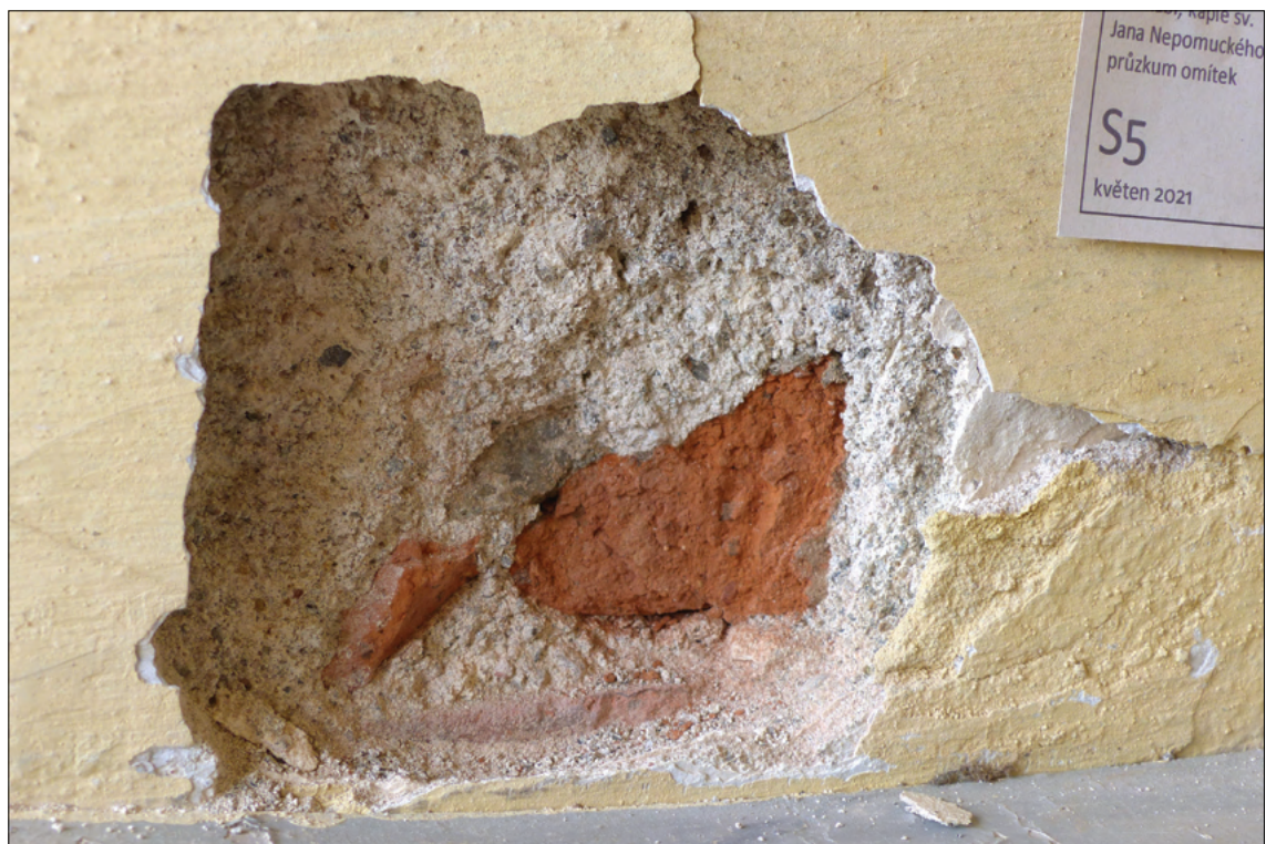
Obr. 53: Detail části sondy S5 s omítkou vysypanou až na cihlové zdivo
