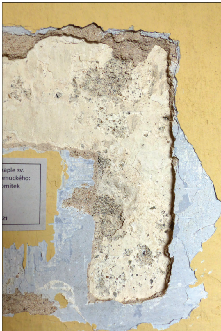
Obr. 61: Detail sondy S7 s odhaleným povrchem původní omítky s vápennými nátěry
