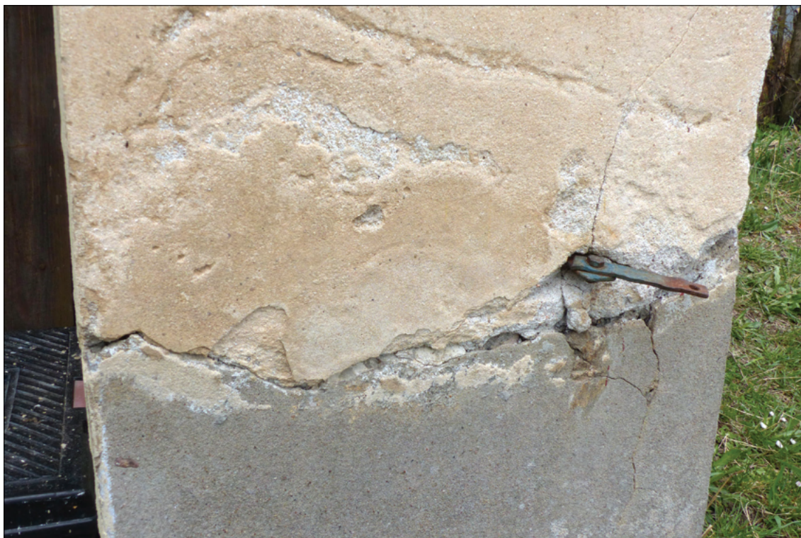
Obr. 35: Detail poškození nad soklem v pravé části vstupní stěny
