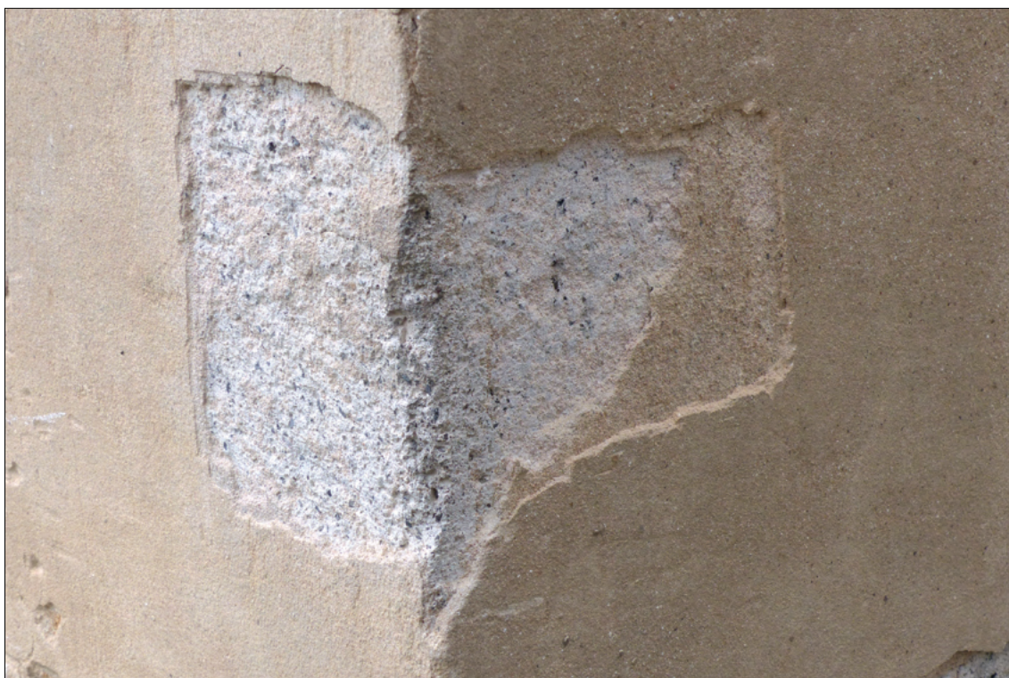
Obr. 26: Orientační sonda na severovýchodním nároží. Na povrchu původní omítky žádné stopy povrchových úprav
