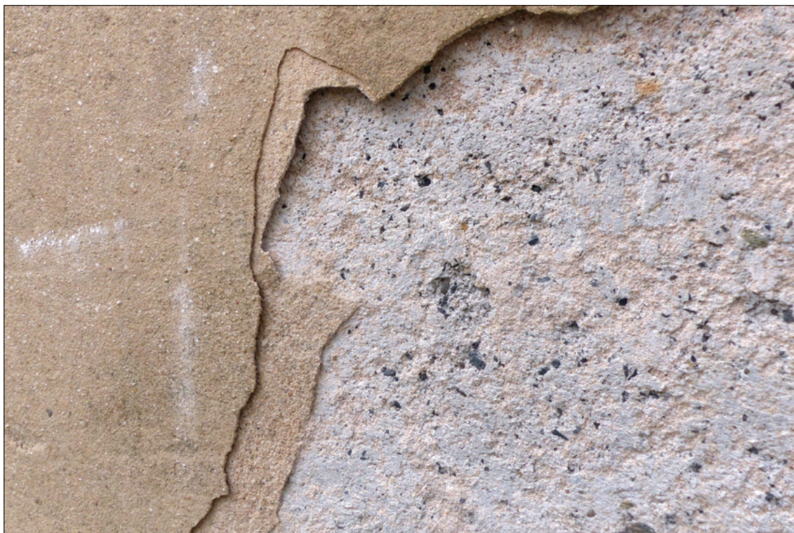
Obr. 19: Detail defektu na severní stěně s dobře viditelnými dvěma vrstvami novodobého šuku
