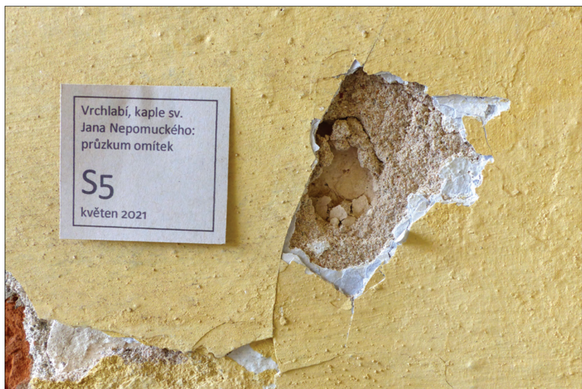
Obr. 54: Část sondy S5 s vydrolenou svrchní štukovou vrstvou
