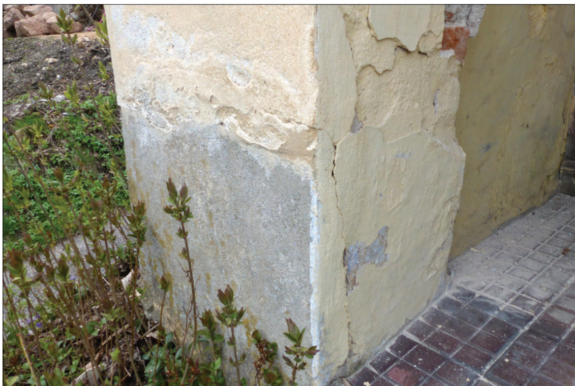
Obr. 33: Soklová partie levé části vstupní jižní stěny s cementovým soklem a výrazným poškozením omítky ve špaletě
