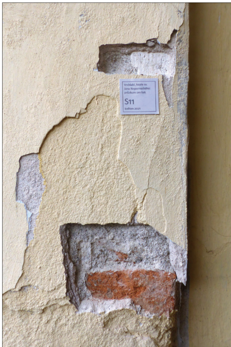
Obr. 67: Detail poškozené a někdy vyspravované omítky ve spodní části levé dveřní špalety s destrukcí a sondou S11
