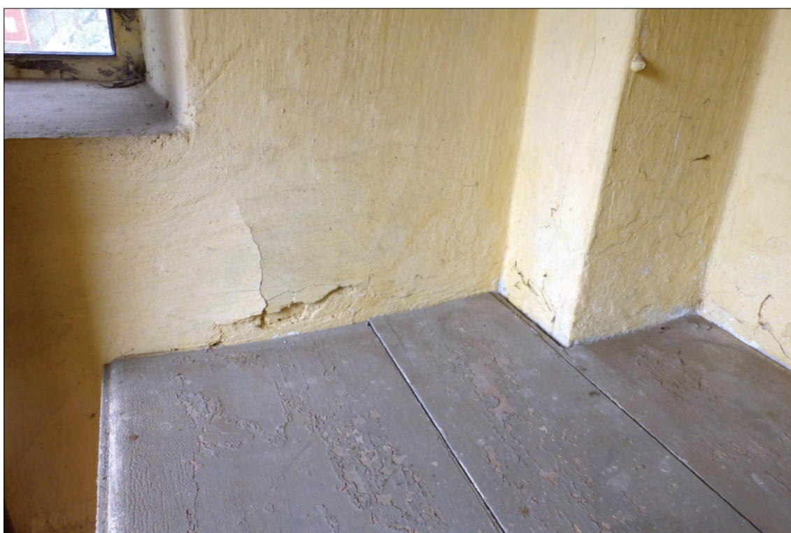
Obr. 42: Defekty v omítce nad levou stranou vestavěného stolu. Poslední světle žlutý nátěr je aplikovaný přes nevytmelená místa
