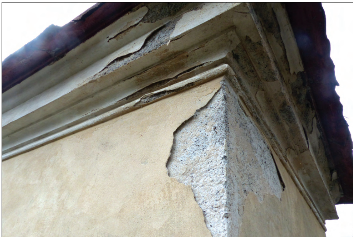
Obr. 15: Severovýchodní nároží s opadávajícími svrchními vrstvami omítky
