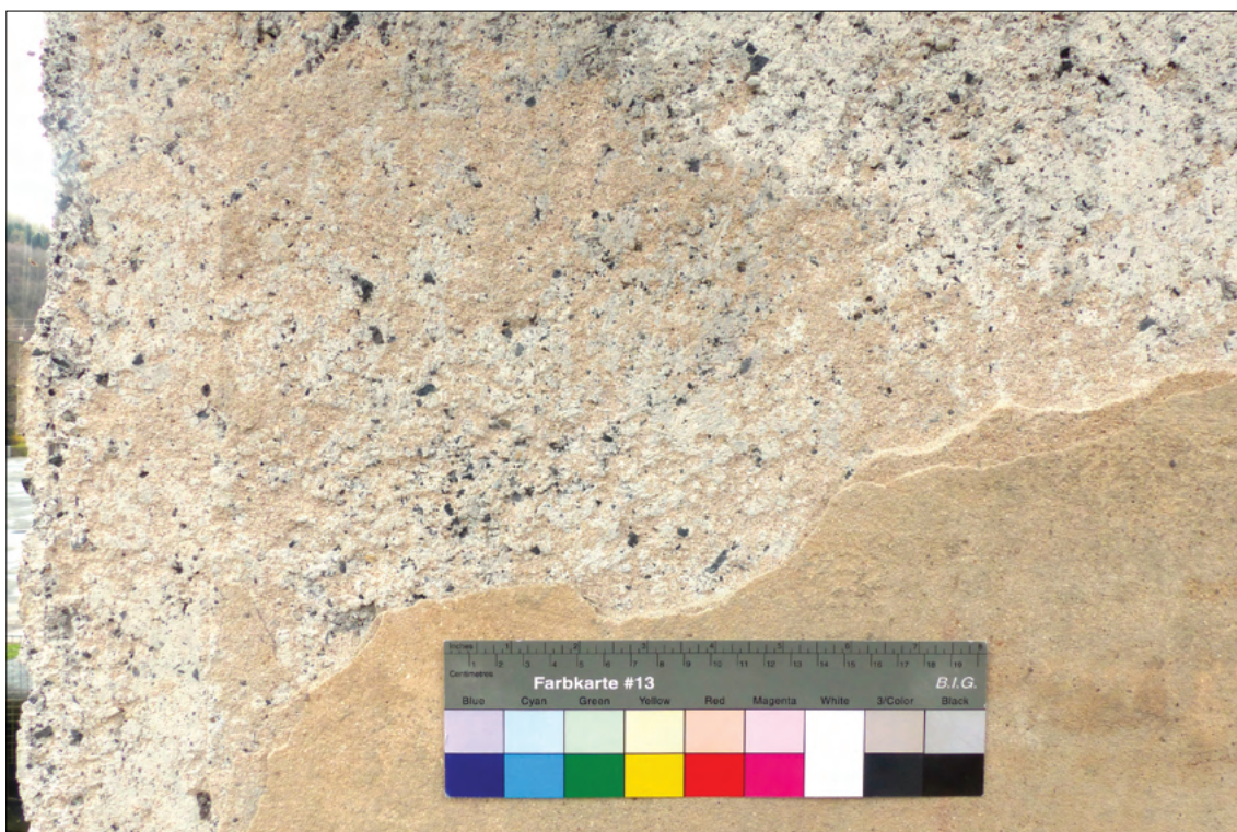
Obr. 22: Detail defektu ve svrchních štukových vrstvách, dobře viditelný barevný rozdíl mezi původní omítkou a novodobými štukovými překryvy
