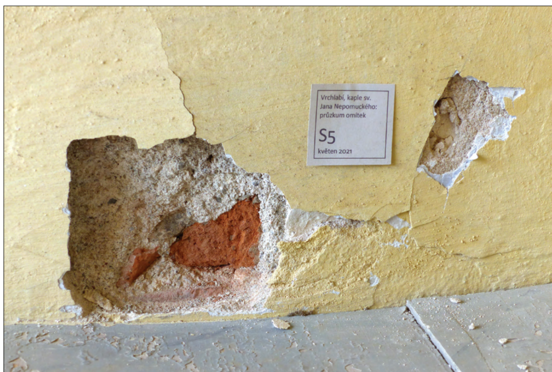
Obr. 52: Sonda S5 v drolících se defektech nad levou hranou vestavěného stolu
