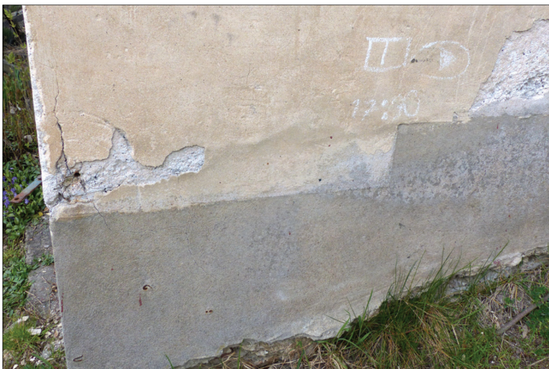
Obr. 30: Detail cementového soklu na východní stěně
