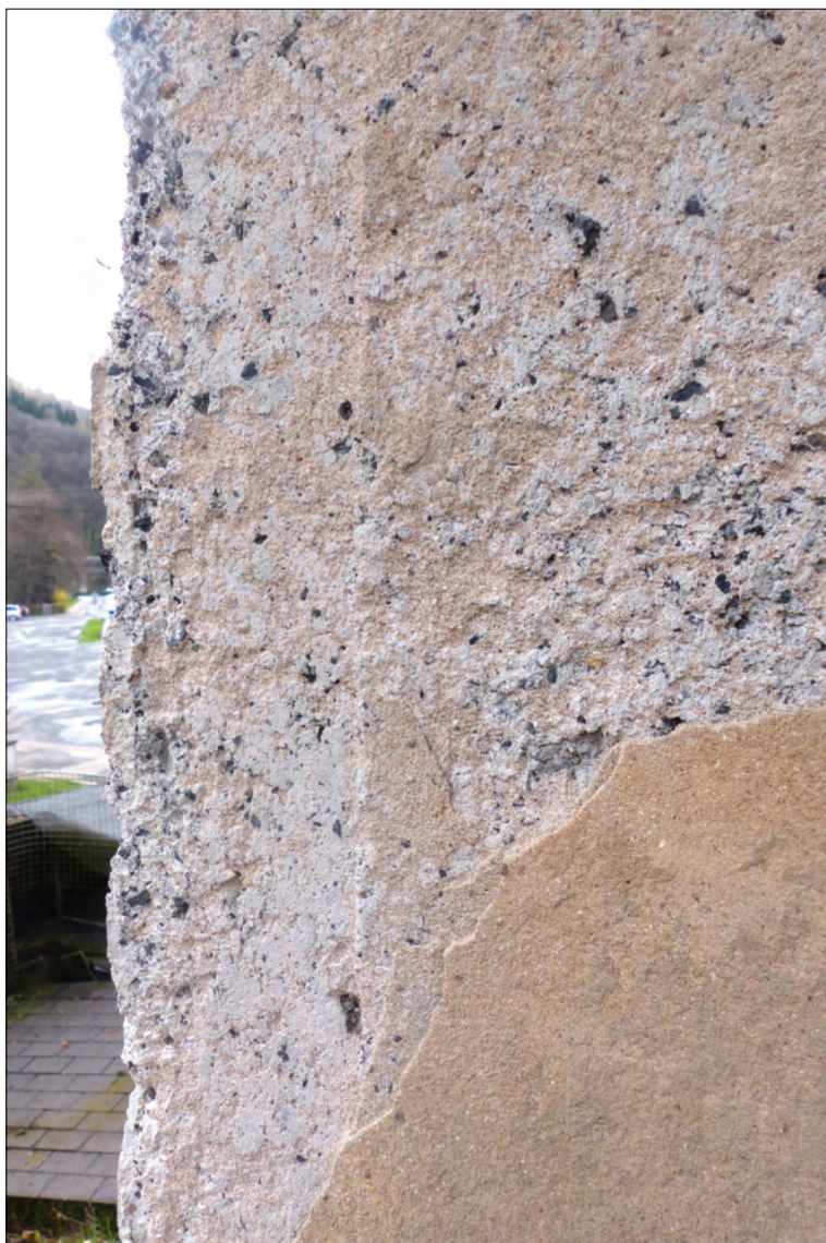
Obr. 17: Nároží na severní stěně, pod opadanou svrchní vrstvou štuky viditelná struktura původní omítky hlazené dřevem
