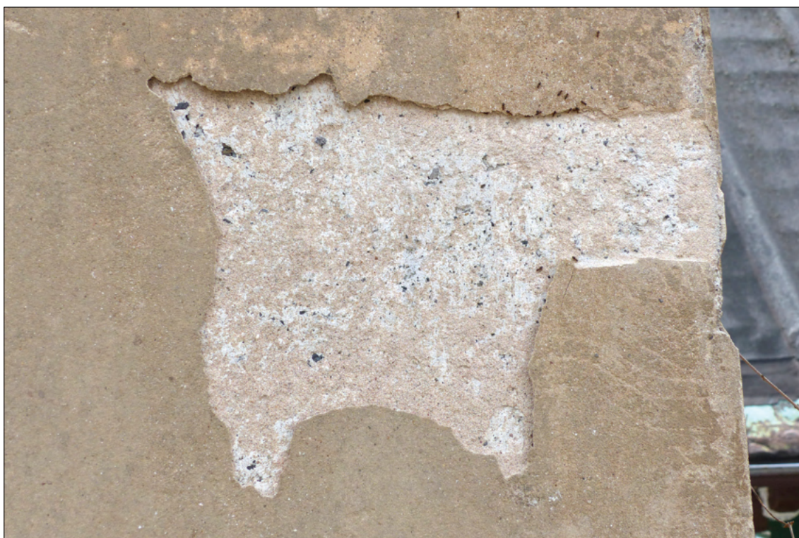
Obr. 24: Detail odlupujícího se štuku na východní stěně. Na nároží není žádná stopa po plastické úpravě (lizéna)
