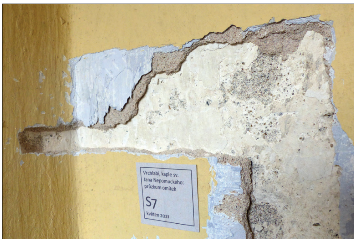
Obr. 60: Boční pohled na sondu S7 s dobře viditelným souvrstvím štuků a nátěrů
