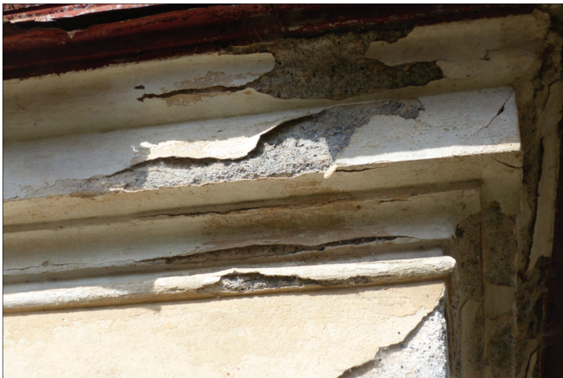
Obr. 9: Nároží korunní římsy s odlupujícími se a opadávajícími svrchními vrstvami omítek
