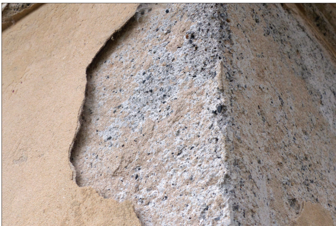
Obr. 16: Detail nároží pod opadávajícím svrchním štukem
