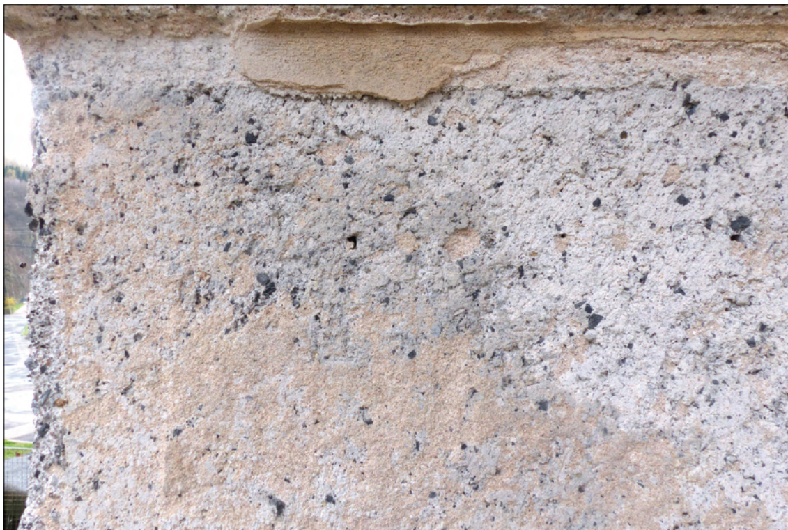
Obr. 17: Nároží na severní stěně, pod opadanou svrchní vrstvou štuky viditelná struktura původní omítky hlazené dřevem
