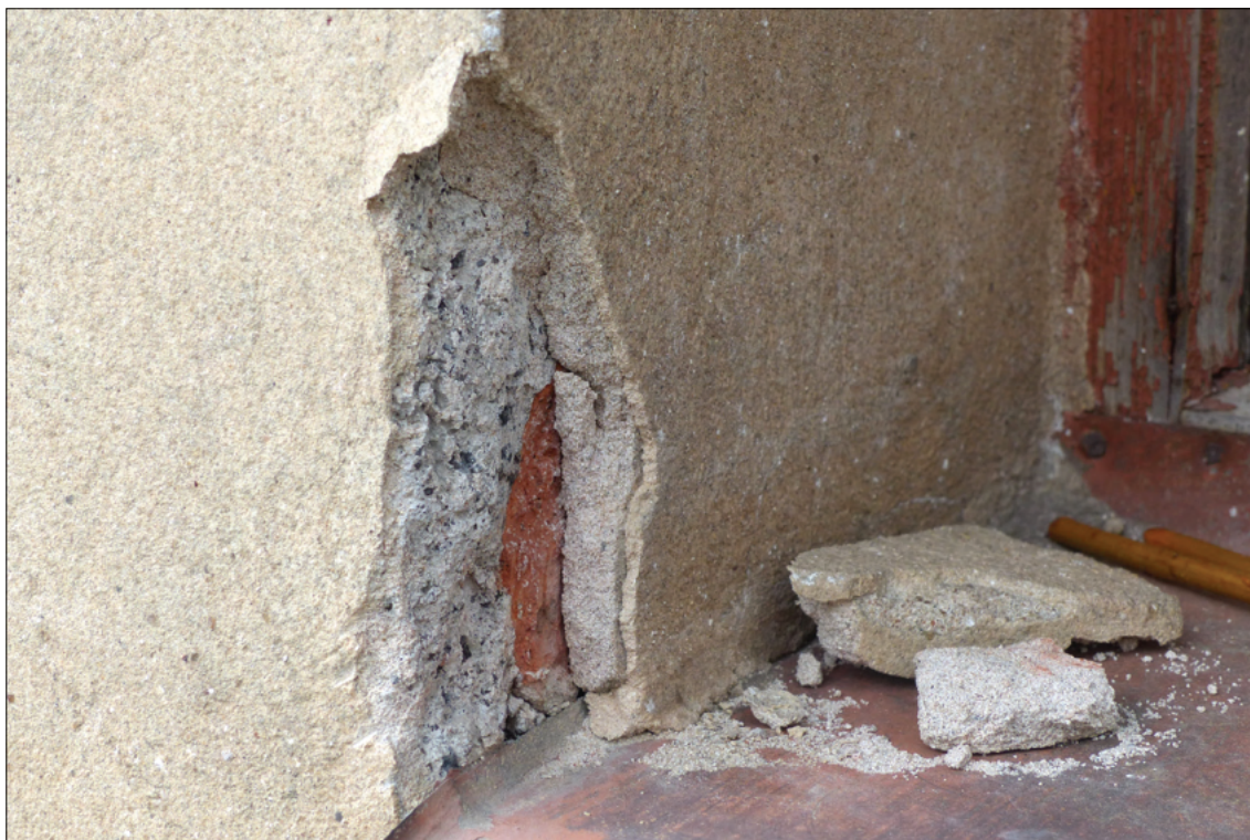
Obr. 23: Detail defektu na nároží okenní špalety ve východní stěně, na lomu viditelné dvě novější štukové vrstvy
