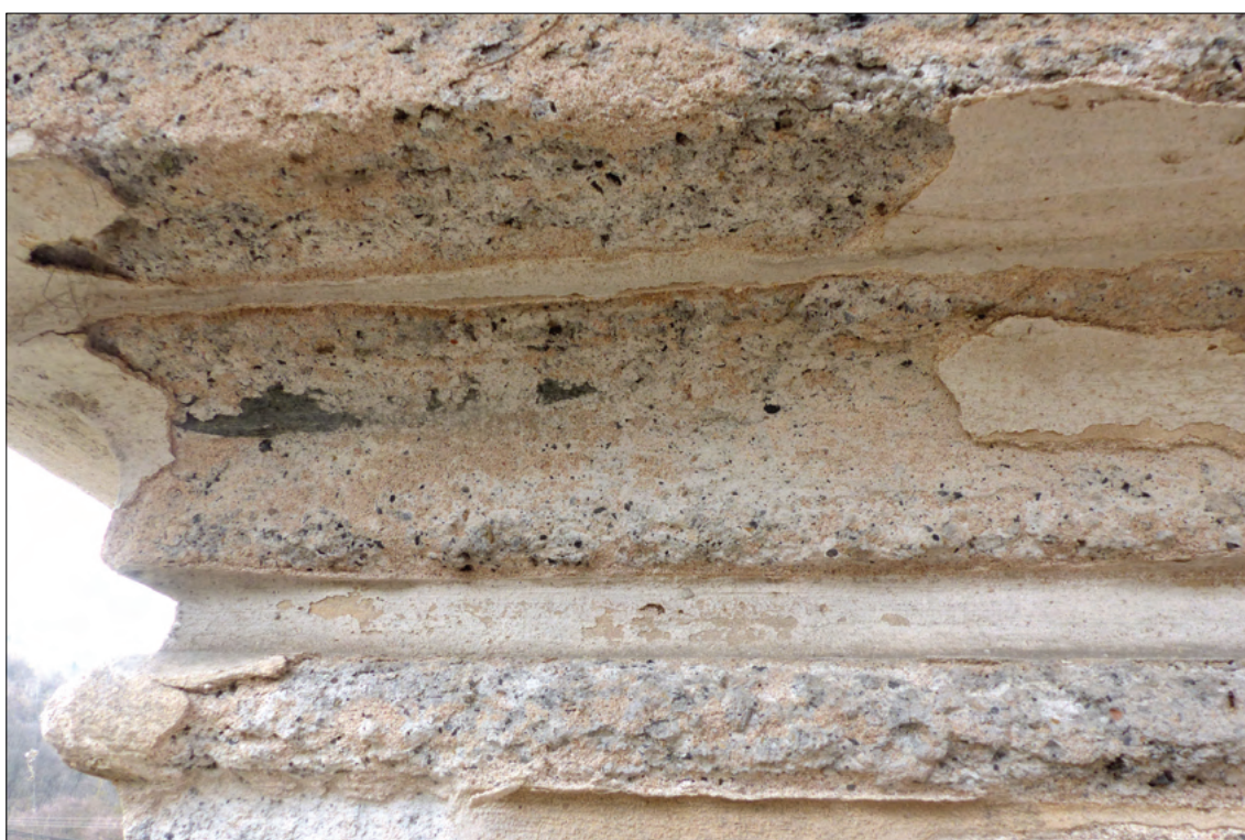
Obr. 12: Detail poškozené omítky na římse. Pod opadanými svrchními vrstvami je viditelná struktura původní malty s velkým podílem drceného dřevěného uhlí
