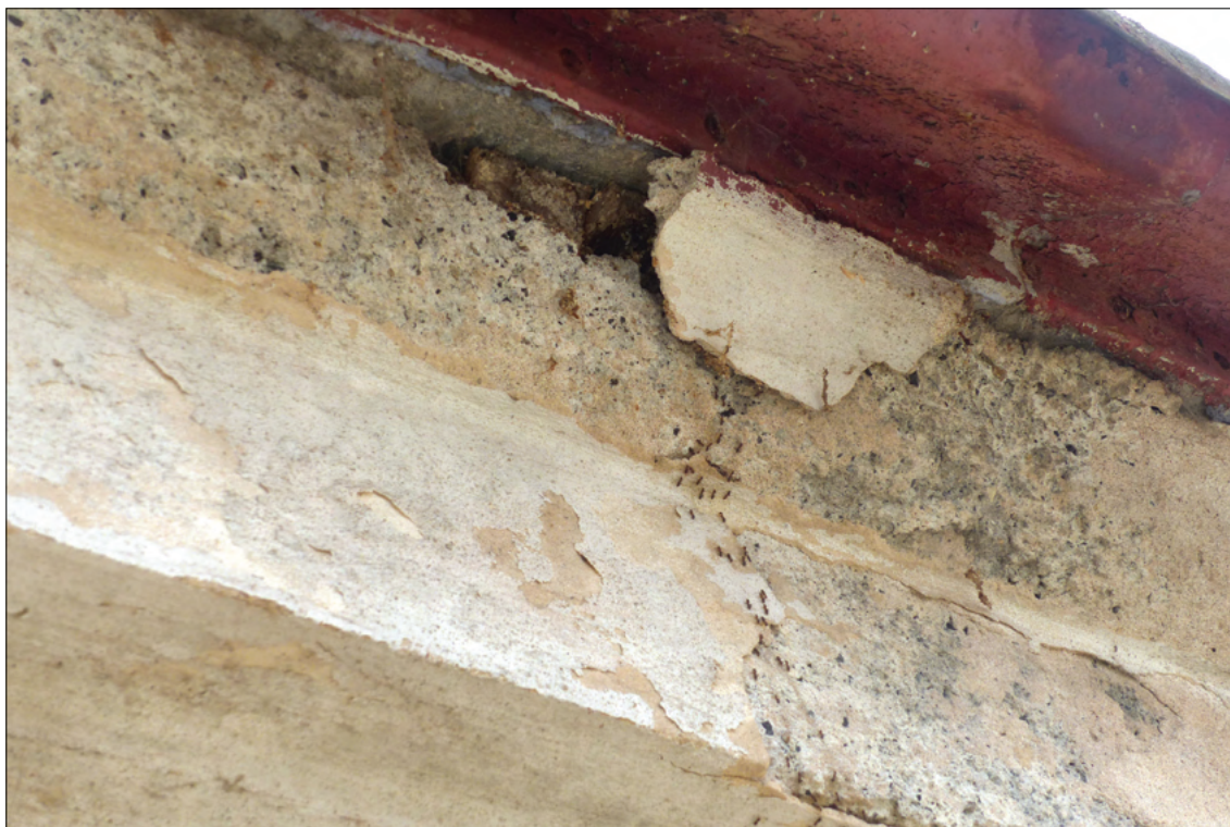
Obr. 11: Detail defektu omítky na římse osídleného mravenci
