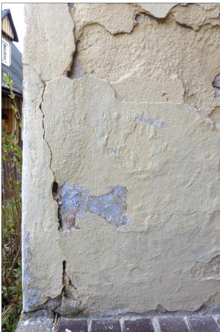
Obr. 33: Soklová partie levé části vstupní jižní stěny s cementovým soklem a výrazným poškozením omítky ve špaletě
