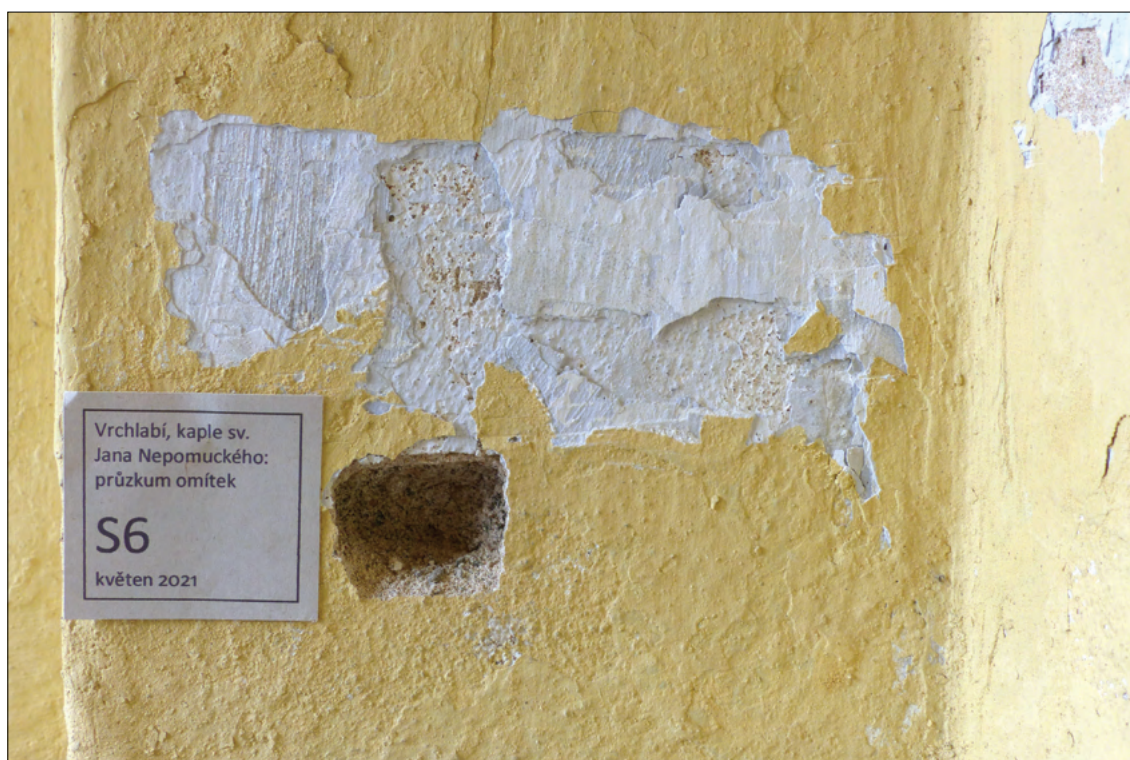
Obr. 56: Sonda S6 s ukázkou tloušťky původní omítky
