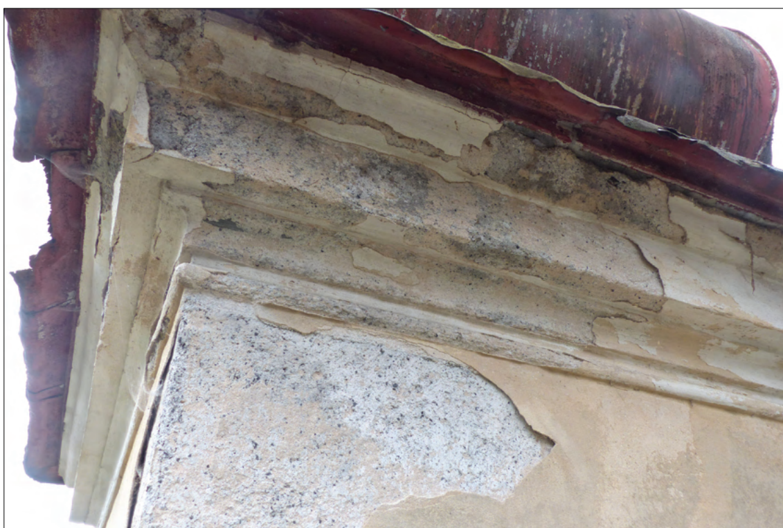
Obr. 10: Nároží korunní římsy s opadávající omítkou a část plochy severní stěny
