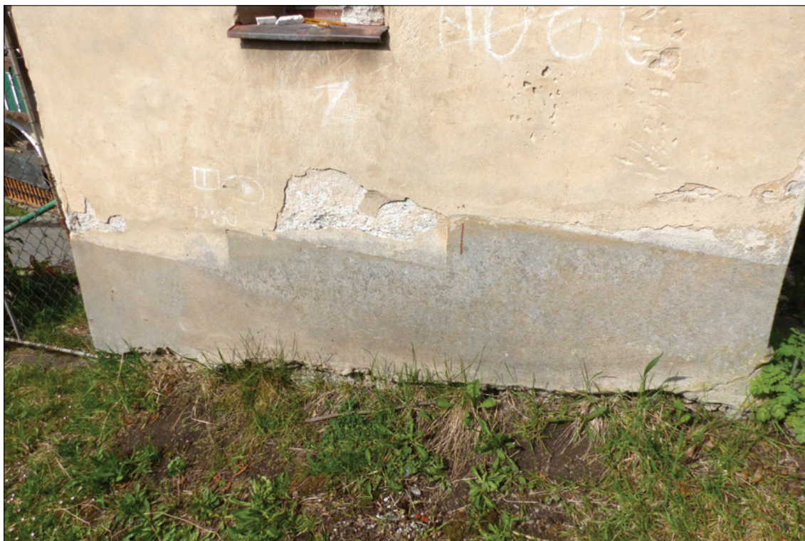
Obr. 29: Spodní část východní stěny s cementovým soklem a s defekty v omítce nad ním
