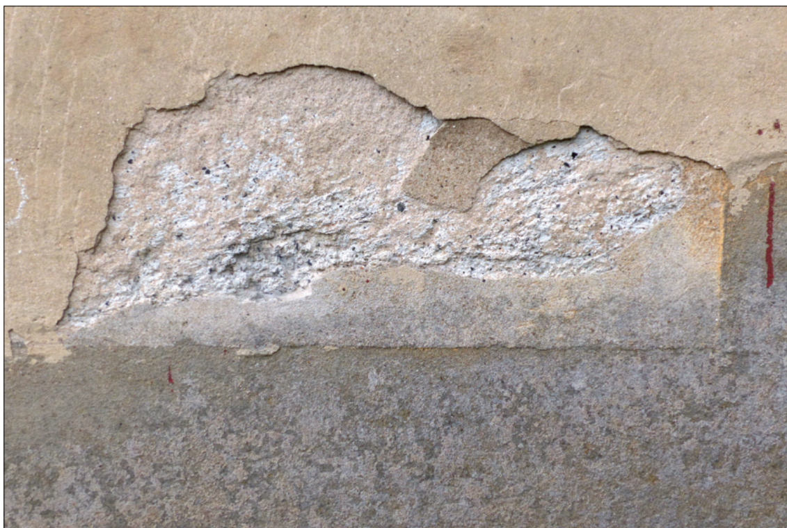
Obr. 31: Defekt nad hranou cementového soklu
