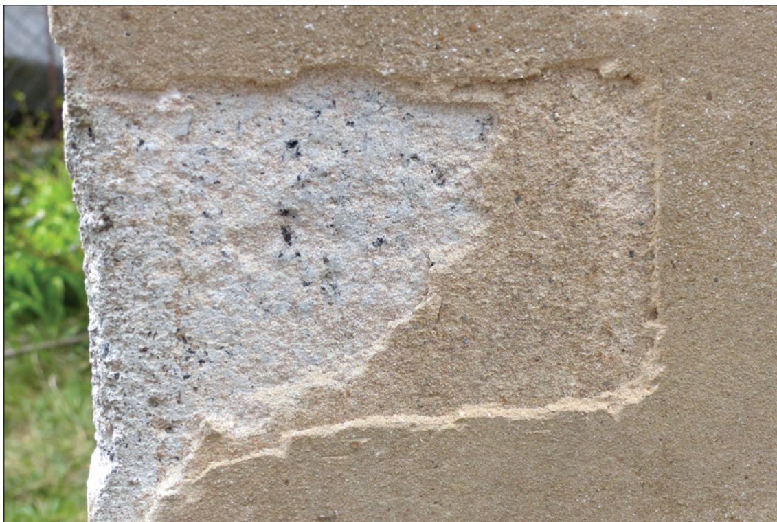
Obr. 27: Detail sondy na severní stěně. Dobře viditelné dvě vrstvy štukového překryvu
