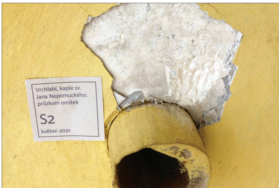
Obr. 46: Sonda S2 se sádrovou plombou u otvoru, kterým byl z krovu spuštěn provaz od zvonu
