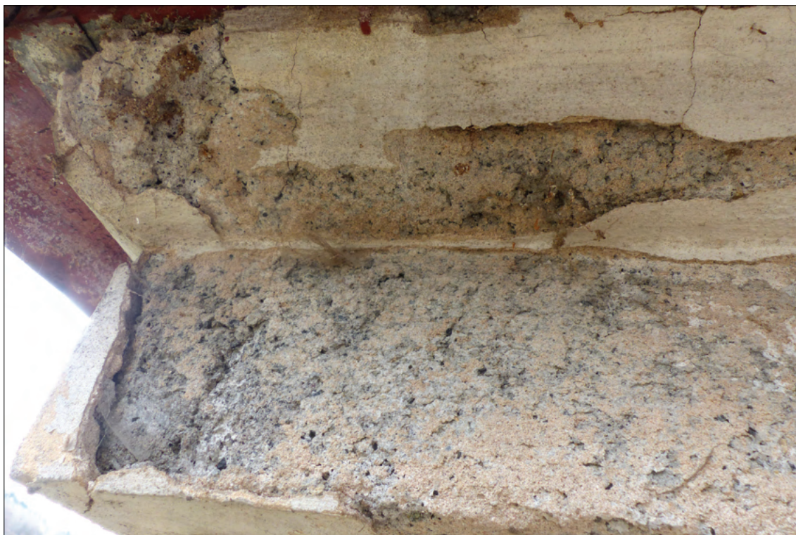
Obr. 13: Detail horní části nároží římsy s hranou domodelovanou částečně opadanou vysprávkovou omítkou
