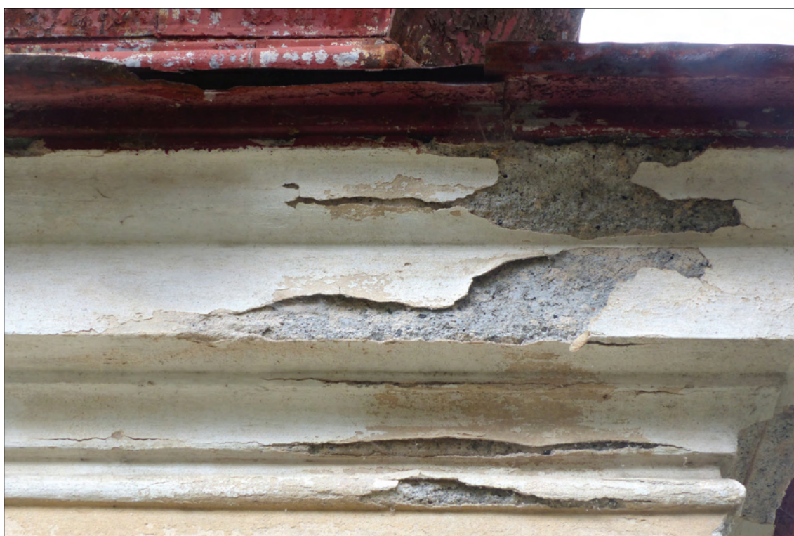
Obr. 14: Detail defektu způsobeného zřejmě dlouhodobým zatékáním přes poškození střešní krytiny
