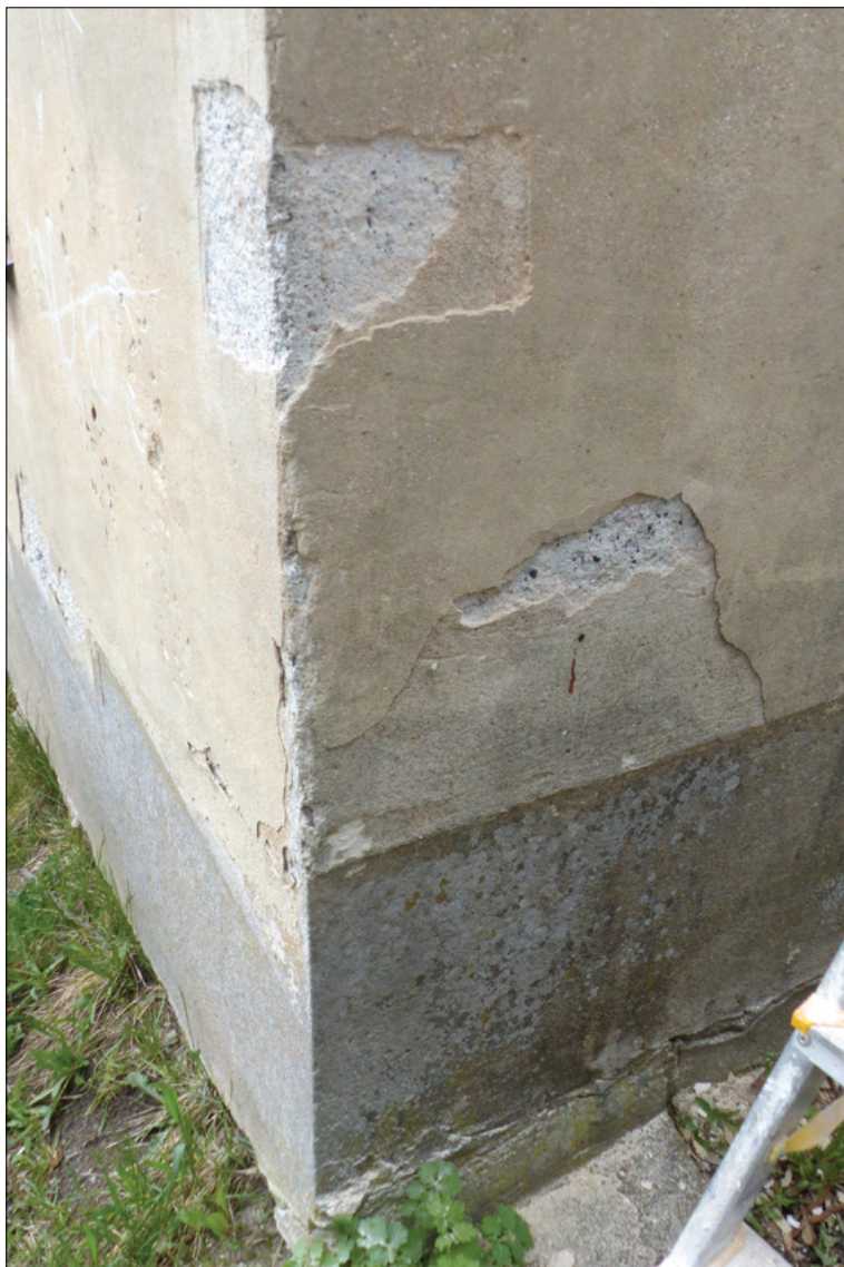
Obr. 25: Spodní část severovýchodního nároží s cementovým soklem a defekty ve svrchních štukových vrstvách
