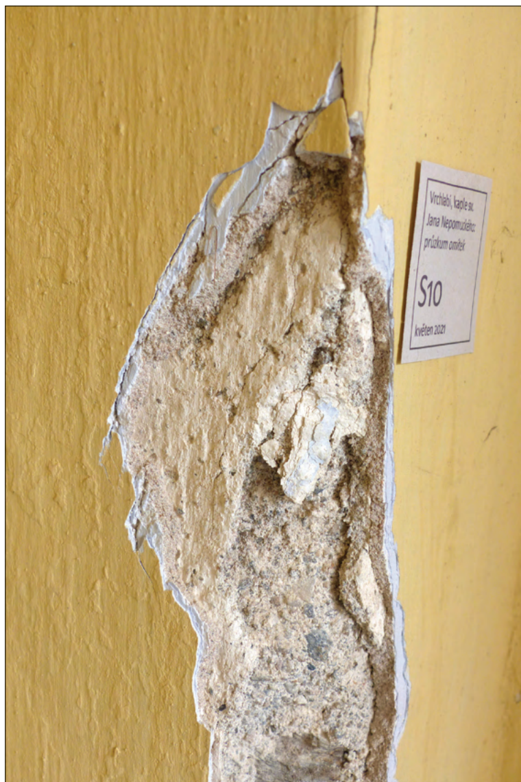
Obr. 65: Detail sondy S10 s poškozenou hranou původní omítky a s částečně opadanými svrchními vrstvami
